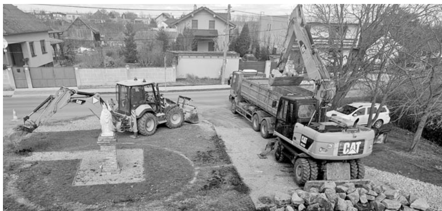
Práce na námestí pred OcÚ
