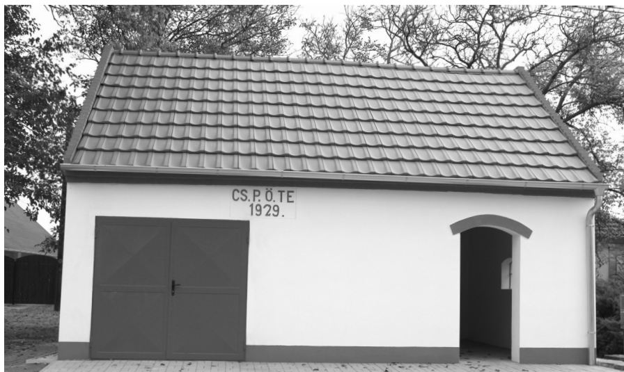
Zrekonštruovaná historická budova hasičskej zbrojnice v Čukárskej Pake
