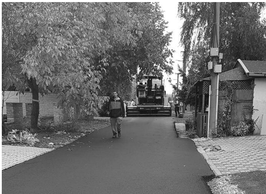
Asfaltovanie na Veternej ulici
