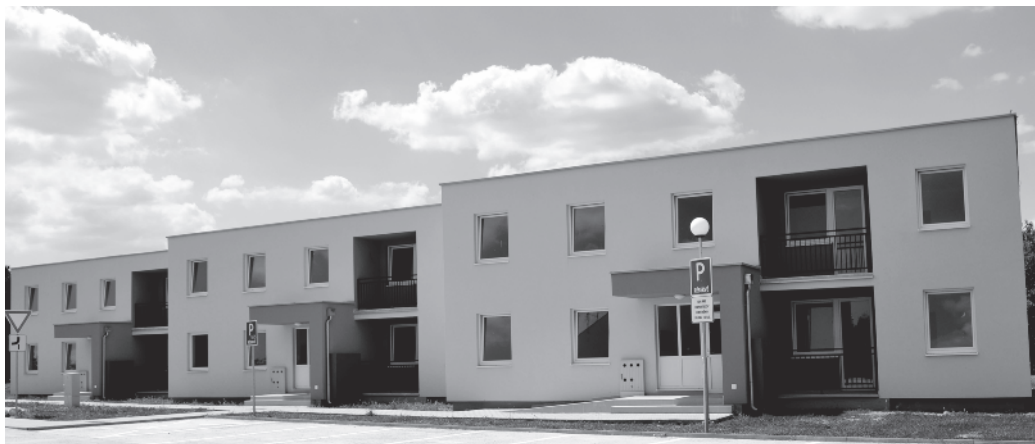
Nová bytovka je pripravená na odovzdanie do užívania
