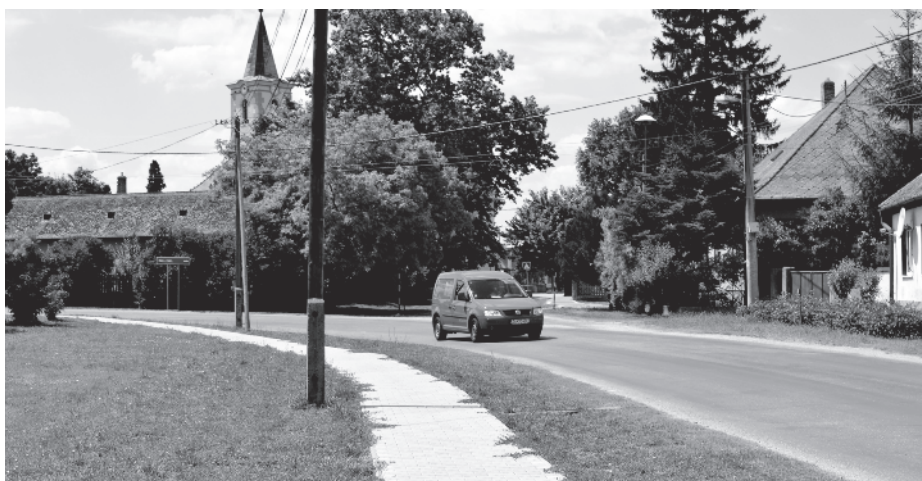
Folytatódik a járdák építése
